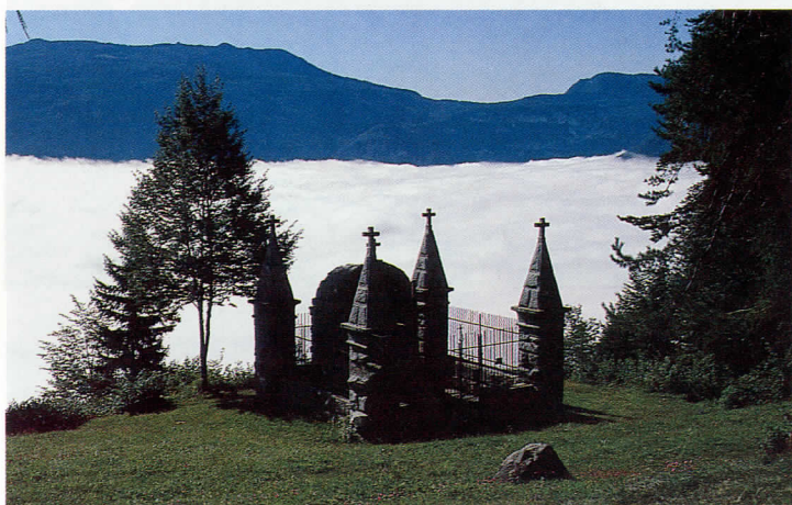
Sas de S. Cros in località La Guarda sul Monte S. Martino.
