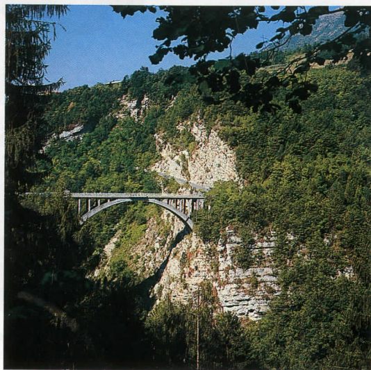
Ponte dei Servi sopra la forra del Limarò.
