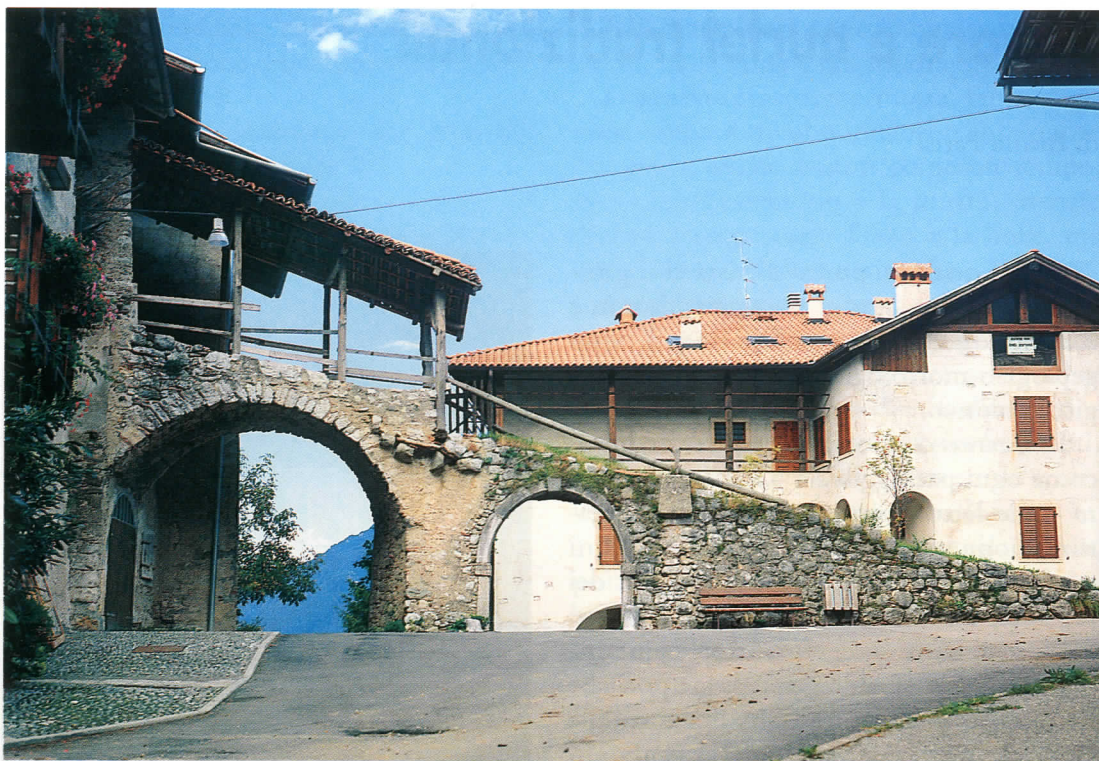
Un tipico esempio di "pont" nell'abitato di Lundo.
